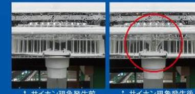
雨水の流れ方 SK40Fは断面積を小さくすることで管内を液体(=雨水)で充滿しやすくしました。
