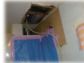
↑天井開口の上配管修理、及び天井ボード・クロス張替
