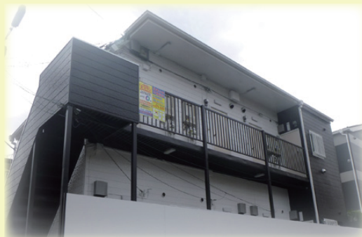
…塗装後の建物…
