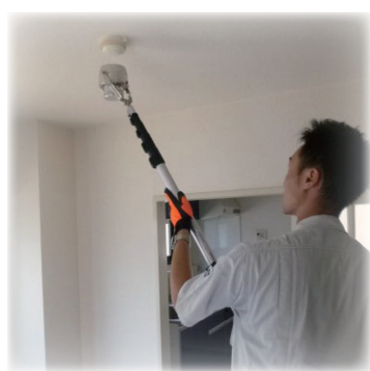
火災警報器点検
