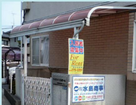
ゴミ置き場上部に、ポリカーボネート製の屋根が設置されています。
